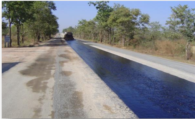
รูปที่ 1.1 การราดยางไพรม์โค้ท (Prime Coat) ชั้นพื้นทาง
