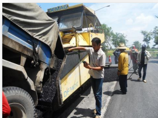
รูปที่ 2.1 การตรวจสอบอุณหภูมิส่วนผสมพาราแอสฟัลต์คอนกรีตก่อนออกจากโรงงาน
