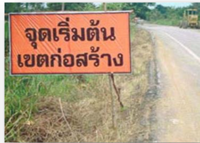
รูปที่ 1.4 ป้ายเตือนเมื่อถึงจุดเริ่มโครงการ
