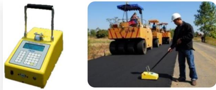
รูปที่ 3.2 การตรวจสอบความหนาแน่นบดทับของงานพาราแอสฟัลต์คอนกรีตในสนาม ด้วยเครื่องมือ Pava Tacker
