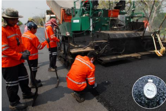
รูปที่ 2.3 การตรวจสอบอุณหภูมิส่วนผสมพาราแอสฟัลต์คอนกรีต ต้องไม่น้อยกว่า 156-170 องศาเซลเซียส
