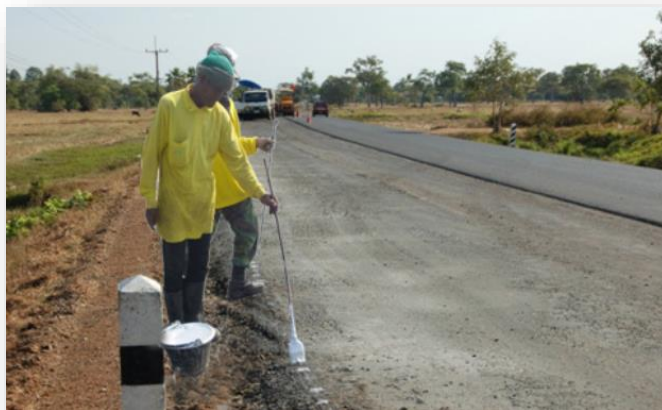
รูปที่ 1.1 การราดยางไพรม์โค้ท (Prime Coat) ชั้นพื้นทาง
